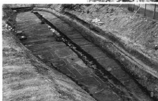
(左) 水田跡全景 (右) 水田跡調査風景
