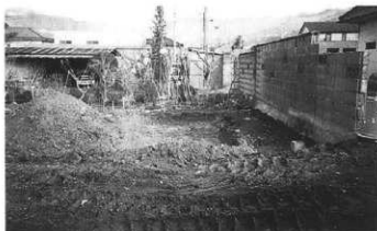
トレンチ完掘状況（南より）
