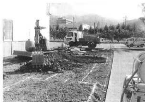
5. 金井遺跡立会い調査状況(西より)
