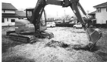
トレンチ掘削状況 (北東より)
