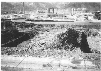
トレンチ完掘状況（東より）
