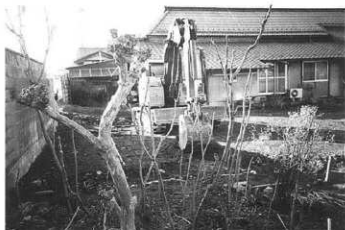
トレンチ掘削状況 (北より)
