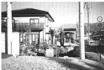
トレンチ掘削状況 (南より)
