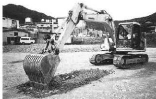
トレンチ掘削状況 (東より)
