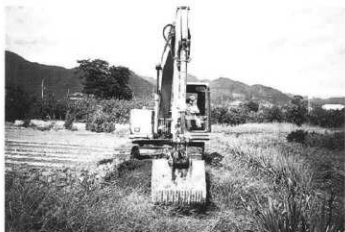
トレンチ掘削状況 (東より)
