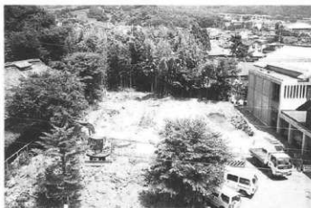
トレンチ完掘状況（西より）
