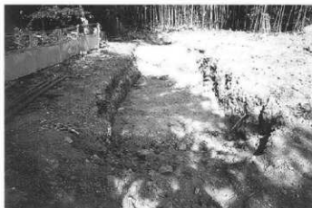
3号トレンチ検出状況（西より）
