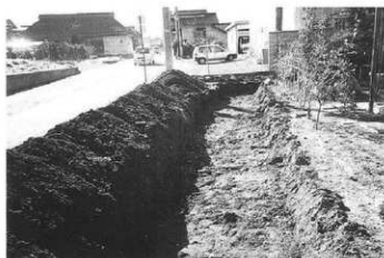
トレンチ検出状況（北より）
