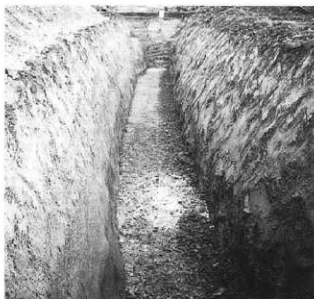
2号トレンチ検出状況 (西より)
