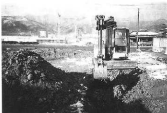
1号トレンチ掘削状況1 (東より)
