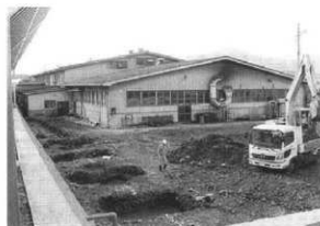
11. 四ツ屋遺跡群立会い調査状況(北より)
