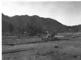
243 保護工事の様子
