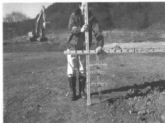
241 盛土保護工事の開始
