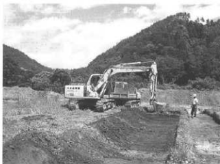
233 重機による表土剥ぎ
