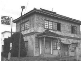
277 坂北村歴史民俗資料館 本庁の旧役場庁舎を展示室として、鉄筋コンクリート通りの収蔵設備を併設している。 (問い合わせ先) 坂北村教育委員会 電話0263・66・3657 電子メールアドレス:kyouiku@vill.sakakita.nagano.jp
