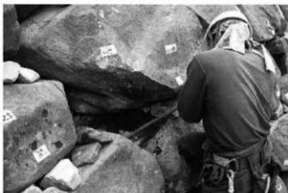
補修工事の様子（裏栗石充填）
