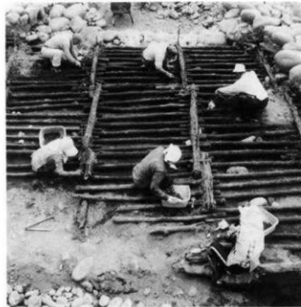
5 木工沈床敷成木面精査作業
