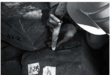
写7-5-4 破断石材のボンド補強（注入）
