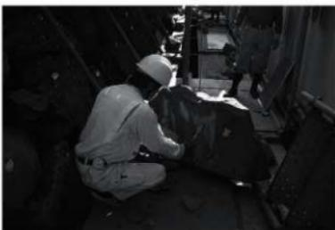
写7-5-3 破断石材のボンド補強（塗布）
