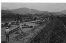
5区 遺構確認作業
