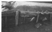
5区 水路内 (杭との間に舟板材)
