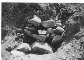
第26図 水抜き暗渠 4 (本丸側)
