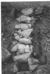
第21図 水抜き暗渠1-1 (蓋石状況)
