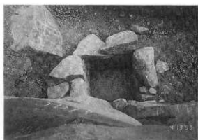
第23図 水抜き暗渠 1-3 (集水拱)
