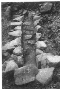
第22図 水抜き暗渠1-2
