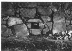
第25図 水抜き暗渠 3 (本丸側)
