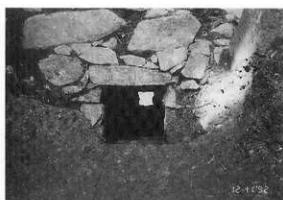
第24図 水抜き暗渠 2 (本丸側)
