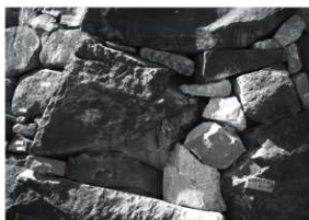
写5-8-13 除去・交換、ボンド補強 (施工後)
