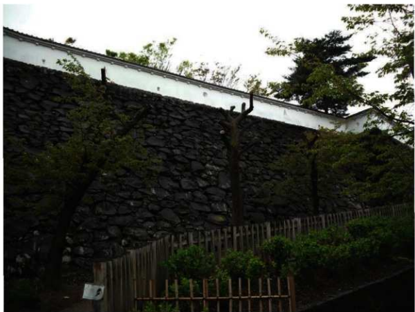
I-32石垣施工前
