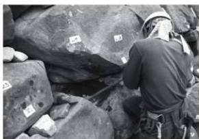
写5-5-8 詰石施工 (栗石充填)
