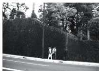
写7-1-2 現状の調査
