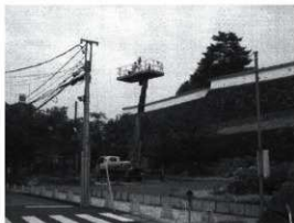
写5-2-1 測量作業の状況1
