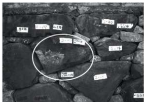
写5-7-9 施工後 (剥離部分の落下防止)
