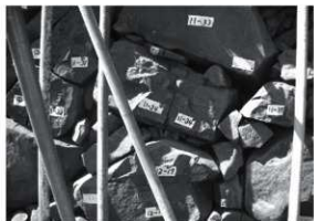
写5-8-6 前後破断石材(施工前)
