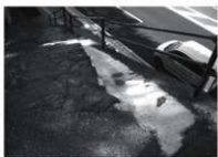
写7-1-4 復旧後の状況
