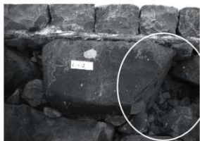
写5-7-6 対比事例③ 施工前
