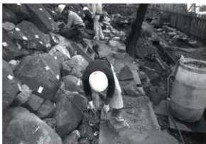
写5-5-7 詰石施工 (石材加工)
