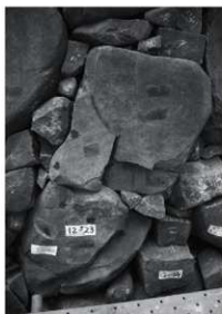
写5-8-11 同右 ボルト・ボンド補強 (施工後)
