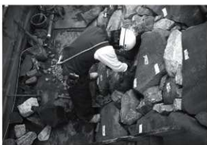
写5-5-9 詰石施工 (補強)
