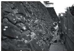
写5-5-6 施工前記録調査
