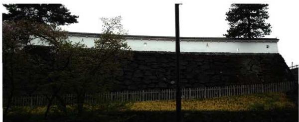
I-30石垣施工前
