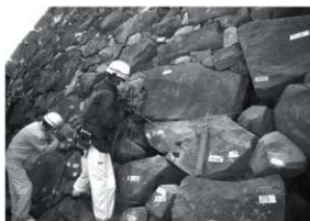
写5-8-3 ボルト施工状況
