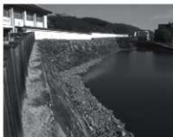
写5-3-3 城内処分後の状況
