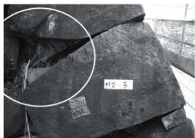
写5-7-4 対比事例② 施工前
