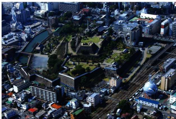
甲府城東より北面石垣を望む
