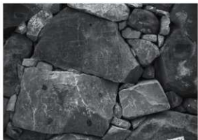
写5-8-8 同上 ボルト補強 (施工後)
