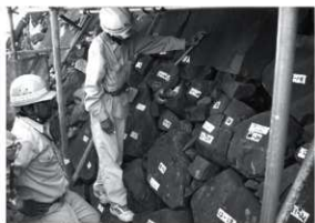
写5-8-2 補強工法の現地協議
