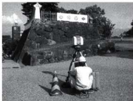
写5-2-2 測量作業の状況2
