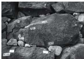
写5-8-5 同左 ボルト補強(施工後)
