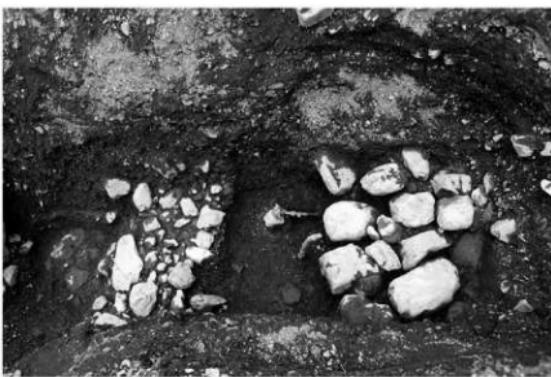
第1 トレンチ北堤木工沈床（C列）および蛇籠（上から）
