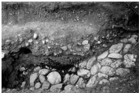
第1トレンチ北堤川表側基底部および木工沈床（西から）
