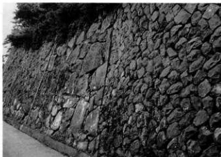
第27図 稲荷曲輪北石垣出隅
