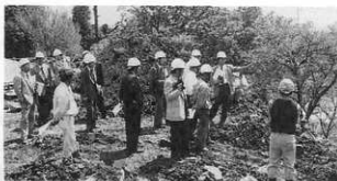
第11回 修復工事現場視察(91.4.20)
