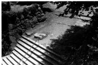
第32図 鋼門北石垣(左上)と鋼門礎石
