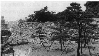
第8図 平成2年度修復工事後石垣
