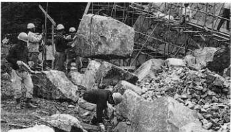
第9図 平成2年度修復工事風景
