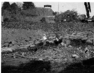
第99図 同左の石垣解体風景
