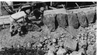
第10図 平成2年度修復工事風景
