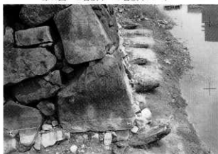
第90図 石垣前面香桐木検出状況
