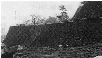
第7図 平成2年度修復工事前石垣
