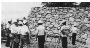
第12回 完成石垣視察(91.7.8)
