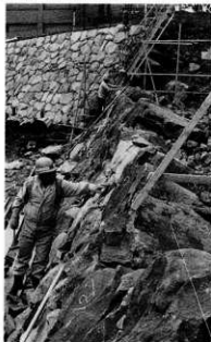
第83図 堀石垣修復工事風景
