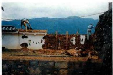
解体に伴う、檜台C面に接していた堀の撤去作業
