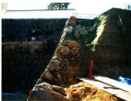
写8-3-1 槽台断面掘削状況
