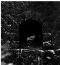
3. 横吹堰堤 水抜き穴 (右:小、左:大)
