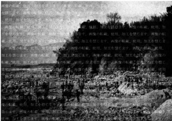
2. 山梨懸東山梨郡勝沼町地先 富士川流域日川筋砂防工事右岸水制第九號十號頭部築石及混凝土施工中ノ状况
