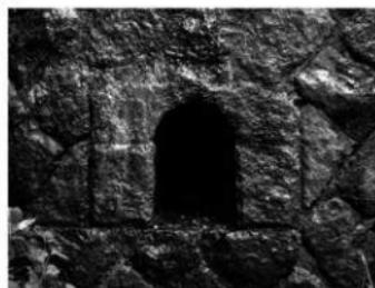
3. 欄小屋澤堰堤 水抜き穴 (1)
