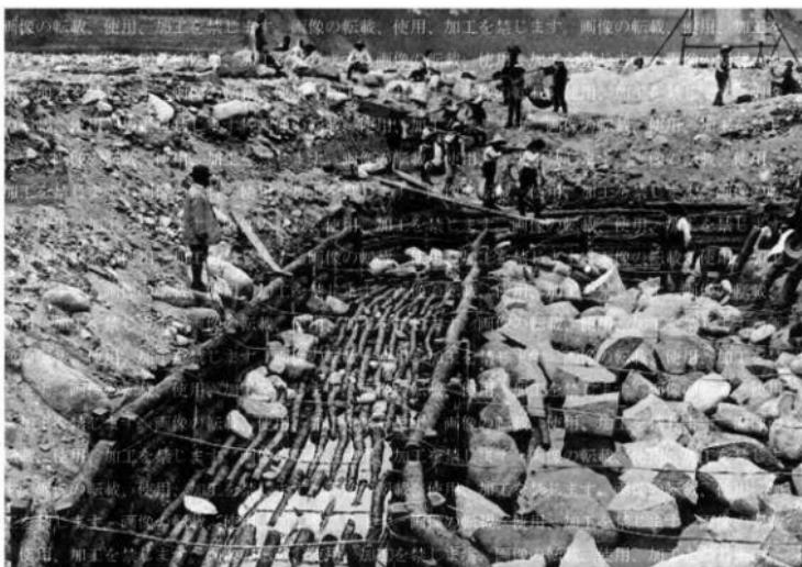
2. 山梨懸東八代郡祝村大字下岩崎地先 富士川流域日川筋砂防工事左岸水制第三十號木工沈床工事中ノ状況
