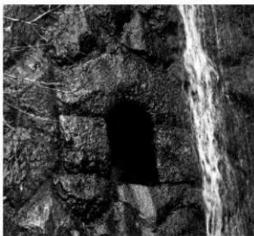
3. 門井澤堰堤 水抜き穴
