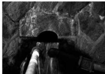
4. 欄小屋澤堰堤 水抜き穴 (2)
