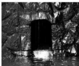
3. 長垣堰堤 水抜き穴
