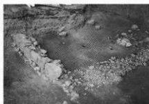
第57図 勸業試験場・米蔵の基礎
