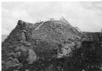
第48図 天守台石垣解体状況
