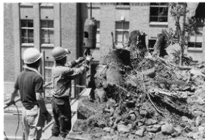
第73図 鍛冶曲輪門東西石垣解体風景
