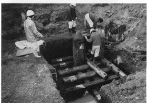
第65図 地中梁調査風景
