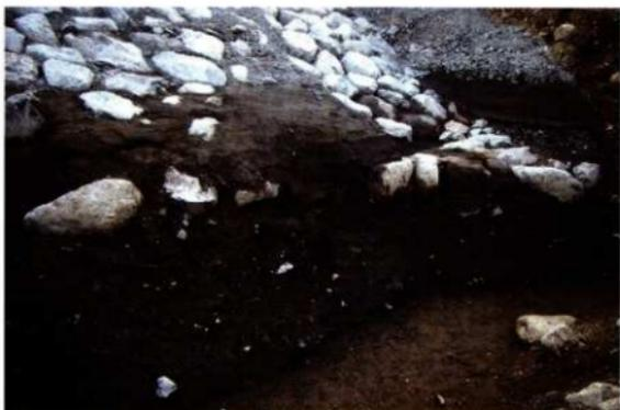
第6トレンチ一番堤（北石堤）川表側梯子土台（木工沈床）断面（北から）
