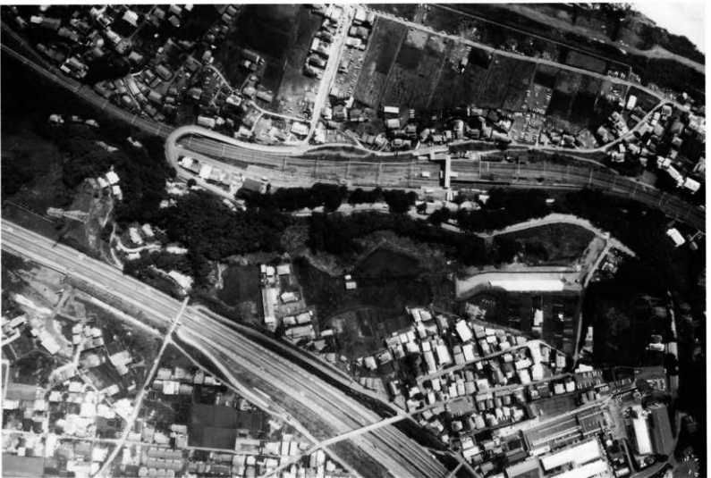
図版 1 関山道路上空航空写真
