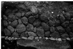
1号石垣（北から）
