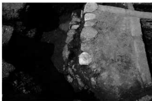
6号石垣（北から）
