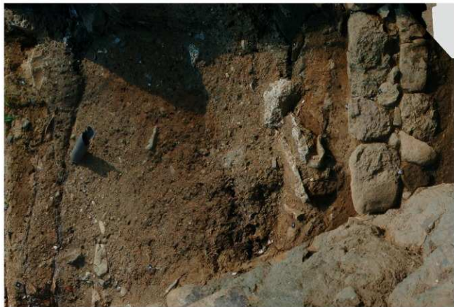
2号石垣 (東から)
