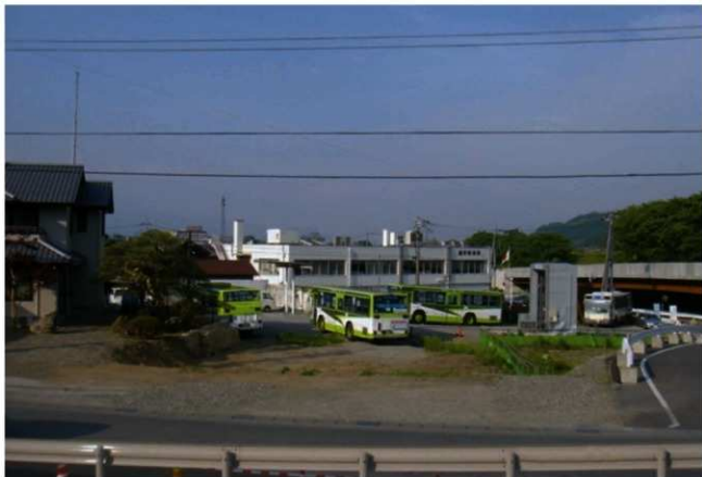
調査前全景（南から）
