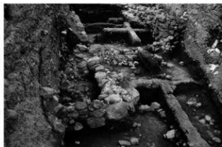
4号石垣 (北から)
