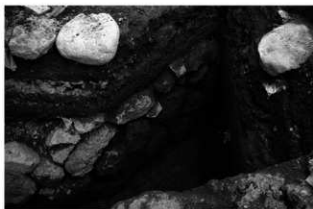
6号石垣（東から）
