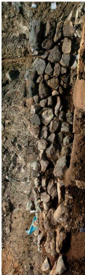
5号石垣 (東から)
