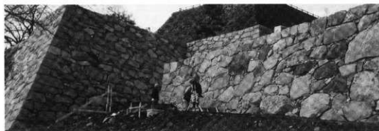
修復された稲荷門石垣
