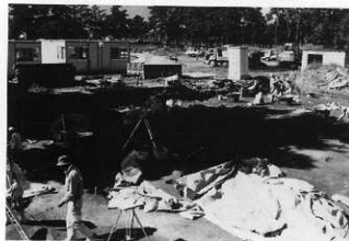
D区 調査状況
