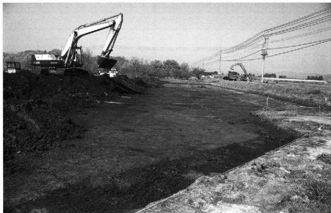
A調査区 表土除去作業状況（東から）
