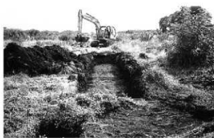
重機による表土除去
