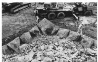
図版20 天守曲輪北東石垣中段部分裏込工事
