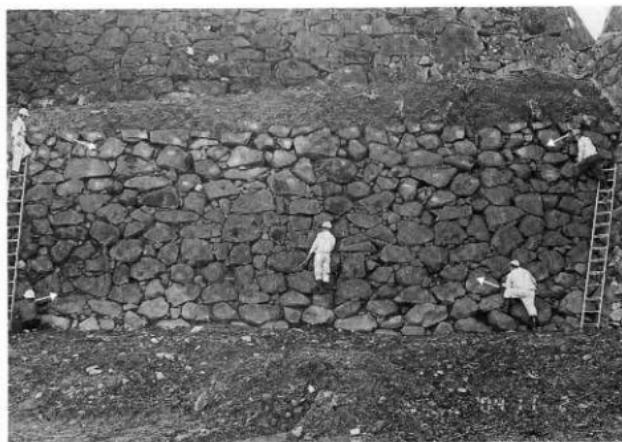
写2-2-1 解体石垣の4点（角）に糸を張り石垣の状態を調査
