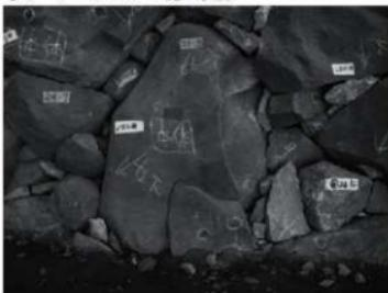
写5-8-5 同左 側面を除去、ポルト補強(施工後)
