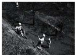
写6-2-13 破損石材除去作業状況
