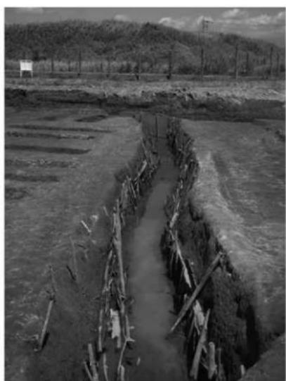
水路の状況（水路の両脇には杭が打たれ、杭と壁の間には板材を入れて水路を保護している。写真左側の水路の上面に打たれた杭は、水害の後に作られた道を保護するための杭と思われる。：南側から撮影）
