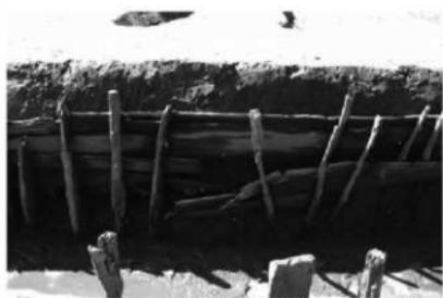
水路内に打たれた杭と板の状況（杭と壁の間に舟板材を入れ、水路を保護している：東側から撮影）
