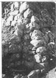
検出された銅門南石垣
