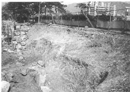
第11図 同上盛土状況
