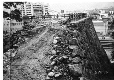
A. 槽台東面石垣断面・裏盛土
