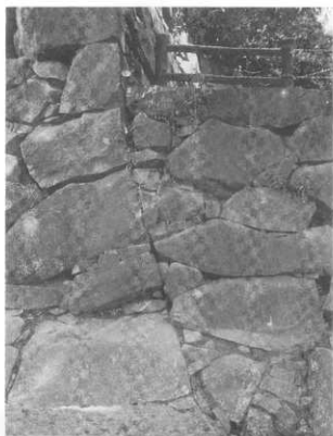
第24図 埋殺された稲荷曲輪石垣隅部
