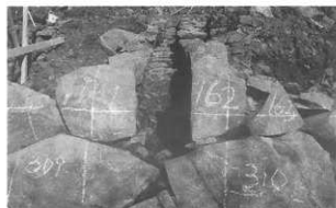
第44図 暗渠解体状況
