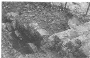
第23図 石段撤去状況
