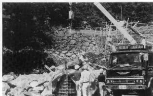
第78図 石材比重測定作業
