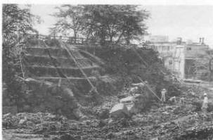
第28図 石積工事風景
