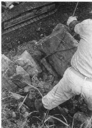
第76図 解体作業
