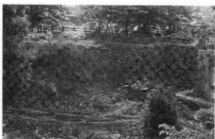
第27図 石垣解体風景
