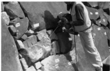
写 4-4-22 ボルトによる補強作業中
