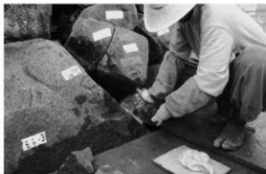
写 4-4-21 接着剤による補強作業
