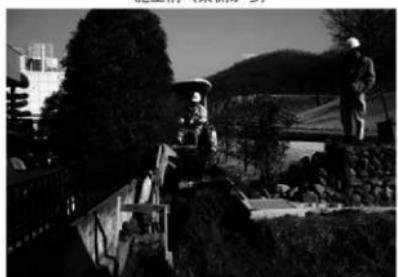
暗渠管を埋設する部分を掘削
