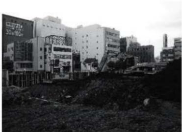
写真12-1-26 埋め戻し作業状況
