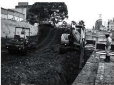
写真 14-3-6 堀内土砂掘削状況
