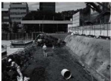
写真 14-3-7 法面補強工事状況
