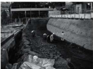
写真 14-3-8 石垣確認面精査状況
