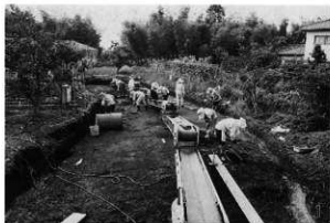
発掘作業風景(東から)
