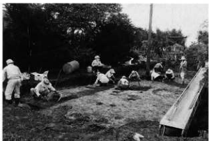
X3~10Y1~10区 作業風景(東から)
