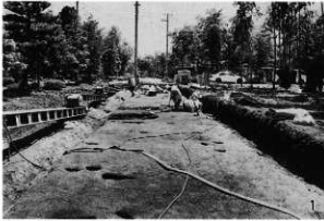
X1~4Y1~25区発掘作業(西から)
