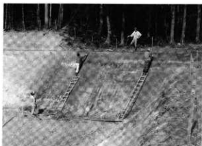
2.作業風景 (後方部西側)
