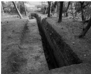
8 第1トレンチ完掘状況（南西から）
