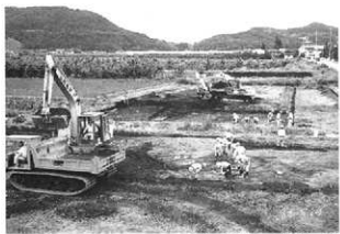
A・B区作業状況（北東から）
