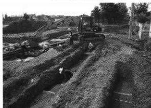
8月14日 試掘調査 (駐車場部分)
