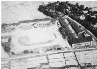
昭和36年頃（増築後）の航空写真
