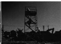
タワー組立風景
