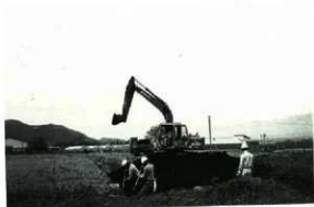
重機による表土除去作業(東から)
