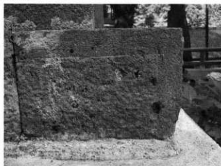
基壇最下壇の縁取（北東隅）
