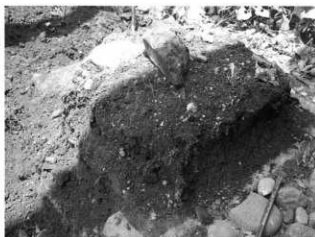
盛土周囲の板石解体後
