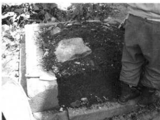
礎石経下の盛土状況
