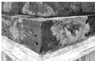
基壇最下壇の縁取（北東隅）
