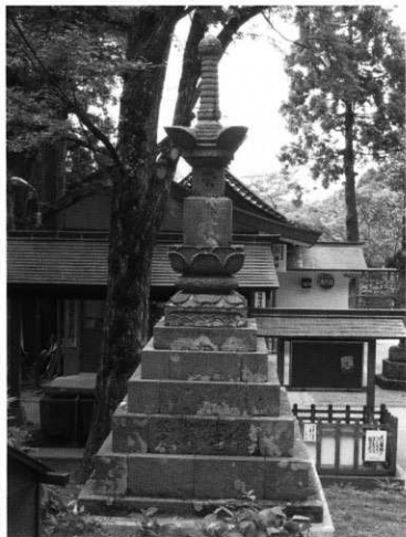
修復後（東から）
