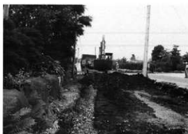
重機導入 (東から)
