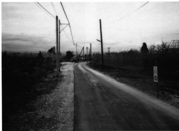
調査前状況 (東から)
