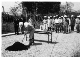
鉄入れ式 (北東から)
