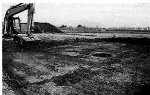
重機械表土除去
