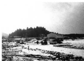
試掘調査状況（北から）
