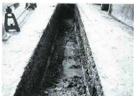
六郎屋敷遺跡立会調査状況 (北から)
