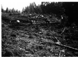
作業風景（北から）
