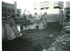
山形城三の丸跡立会調査 (旧県立中央病院解体)
