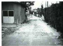
小田島城跡立会調査区近景（東から）
