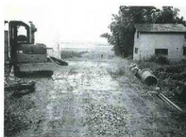
箕輪遺跡近景（北から）
