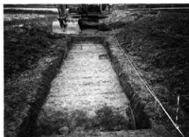
T 1 試掘調査状況 (南から)
