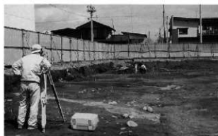
調査区杭打ち作業状況（南から）
