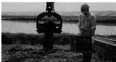
2次調査河川跡鉄鋼矢板打込作業
