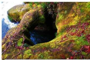
上から見た第1隧道入口 角落し用の枠跡
