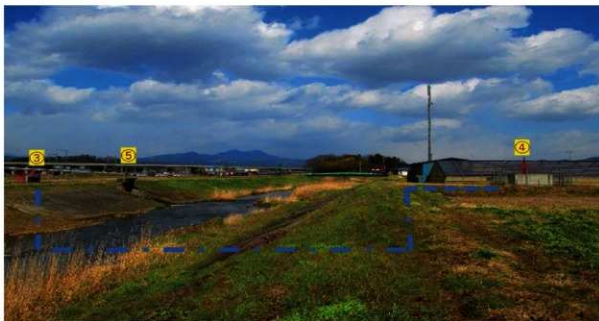
手前が坂谷地区 ③から④へサイホン式で斎が川の下を用水が通過する。用水の必要が無い時は⑤から斎が川へ放水する。
