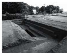
掘削終了状況(北西から)
