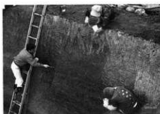
(5) 南壁土層剥ぎ取り状況 (薬品塗り)
