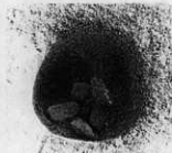
(5)根固め石検出状態
