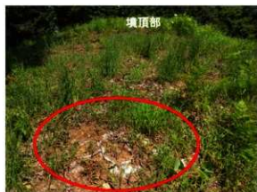
写真 5-5 後円部北西裾イノシシ被害（西から）
