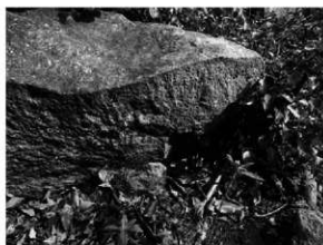
図30 観音寺域・石の目と逆に割れている石材
