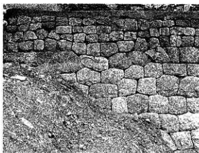
①三ノ丸堀内側石垣正面写真(数字の順に西～東)
