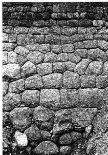
⑦三ノ丸堀内側石垣正面写真（数字の順に西～東）
