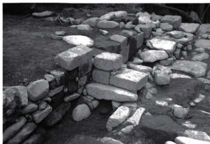
本丸地区西虎口SD2暗渠部分（北東から）
