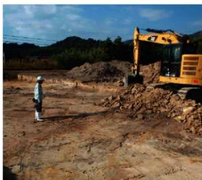
重機による表土除去
