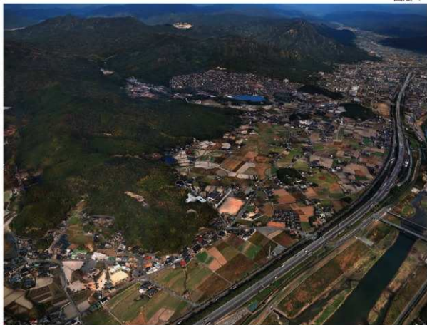
1 遠景①（佐波川河口方面から）
